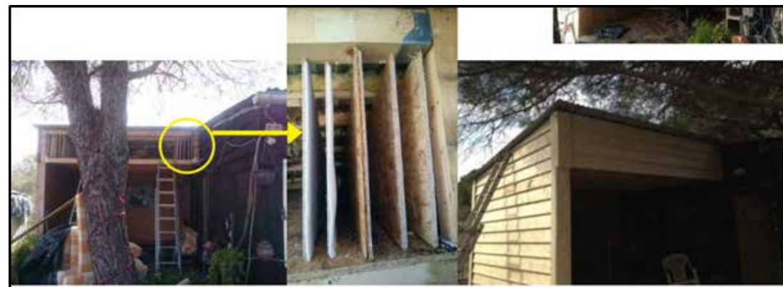
Figure 17 : Abri de substitution réalisé à Marseillan
